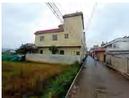
自来水供水管
