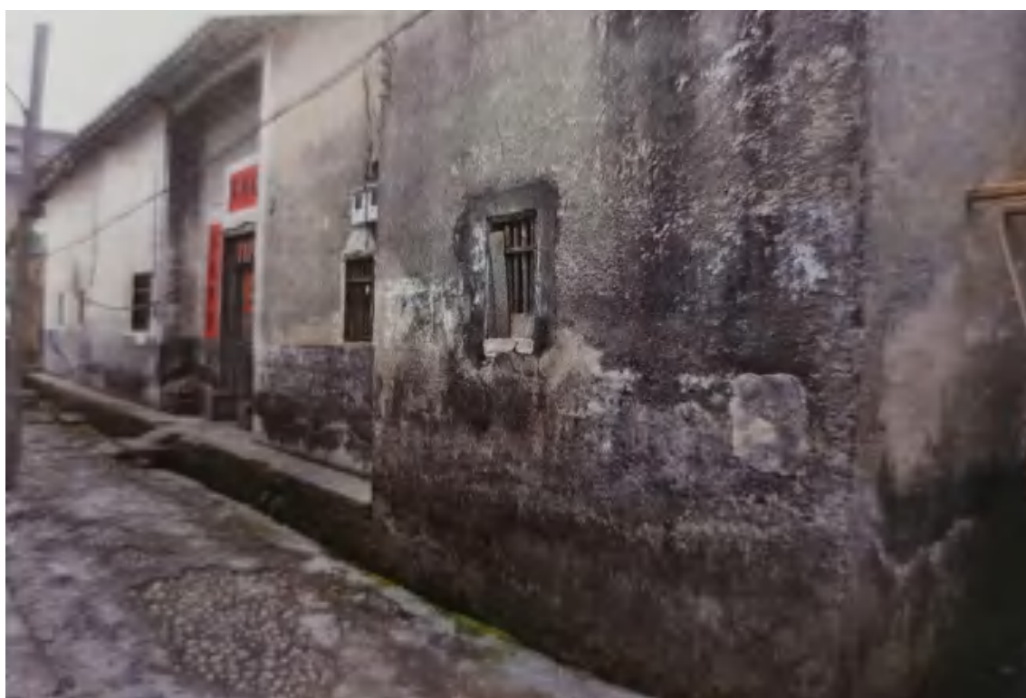
历兴围中巷道
