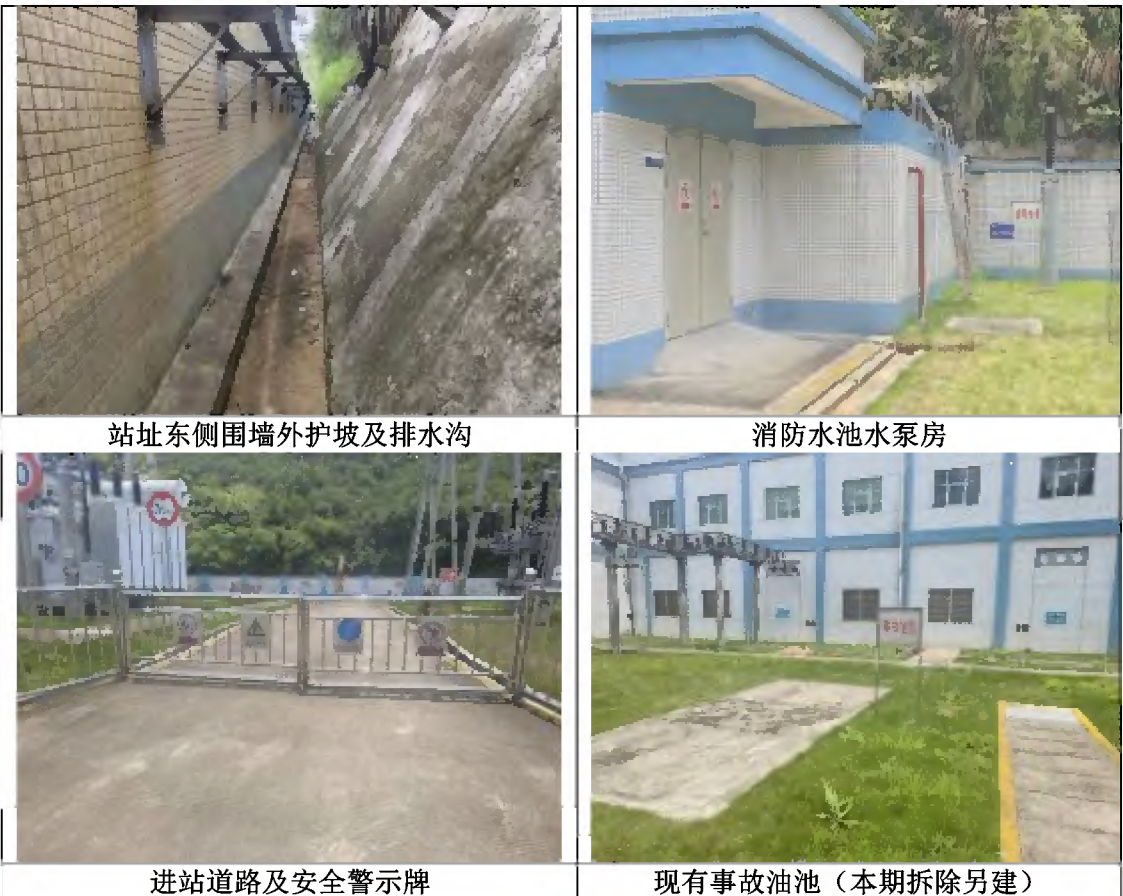
图 2.2-1 东水站现有环保措施照片
